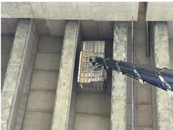
고소점검차를 이용한 근접조사
