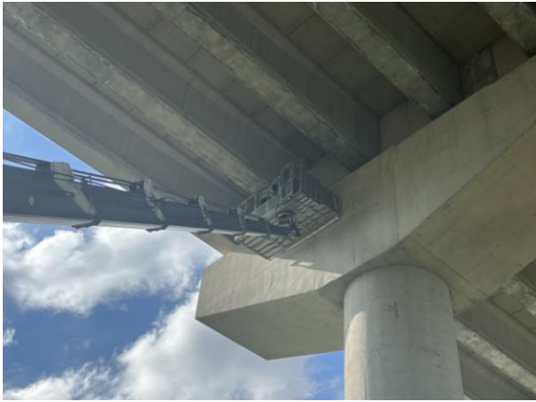
고소점검차를 이용한 근접조사
