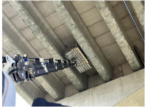
고소점검차를 이용한 근접조사
