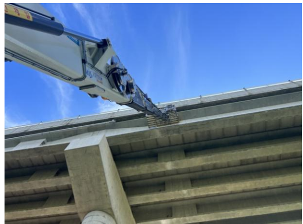
고소점검차를 이용한 근접조사
